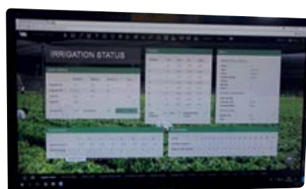
Système de climatisation et d'automatisation informatique نظام التحكم في المناخ وأتمتة الحاسوب
