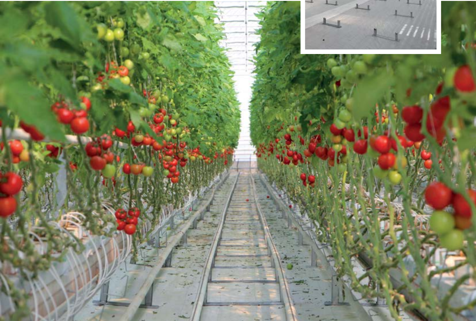
Système de chauffage de rail
