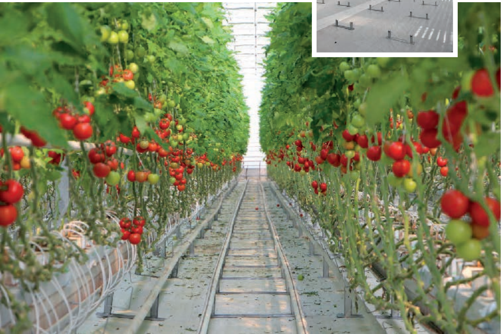
Raylı Isıtma Sistemi Система рельсового отопления
